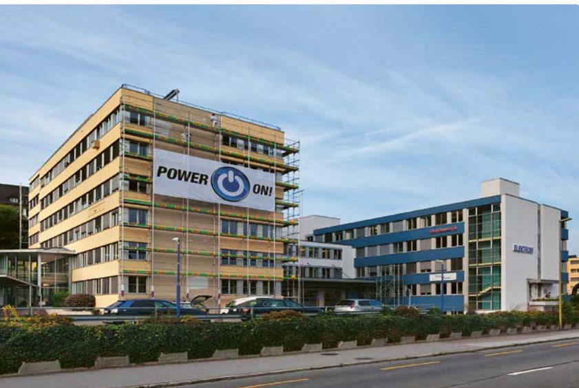
Bevor «power on» das Elektron-Logo ergänzte, zierte eine Blache mit diesem Claim den Firmensitz während einer Fassadenrenovation.
